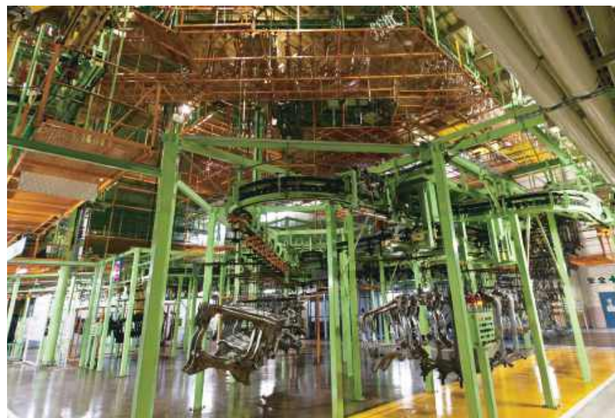
大型のカチオン電着塗装ラインを配備 Large cation electrodeposition coating line is available
